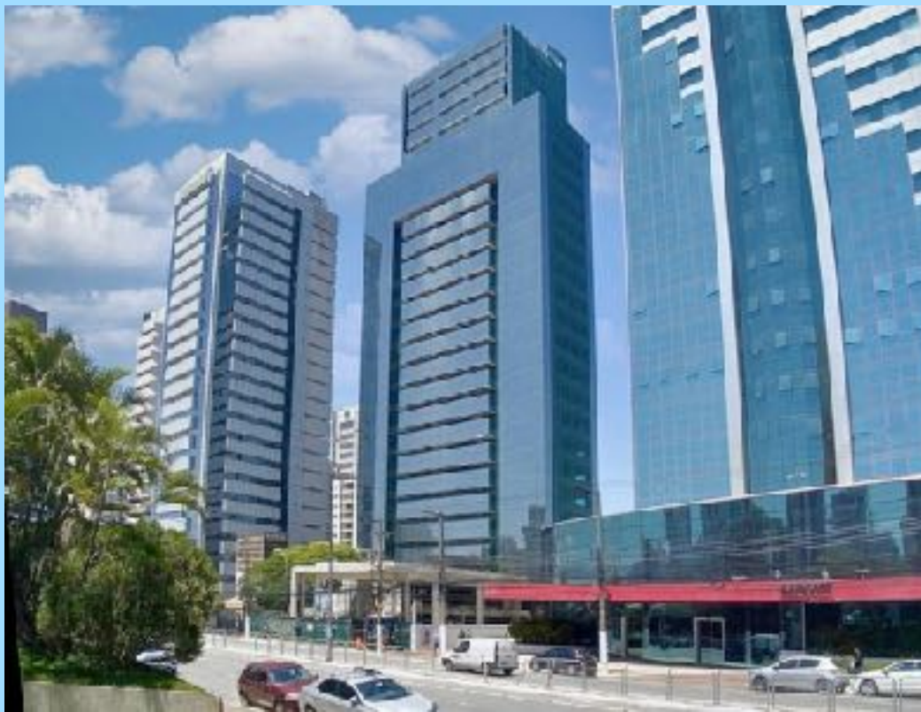
FACHADA ENTRADA RUA VERGUEIRO (FOTO 22/11/2021)
