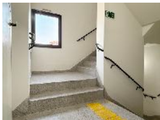
Escada de incêndio
